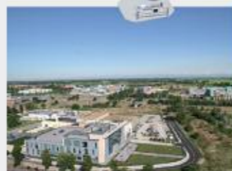
Fig. 3.30: Vista aerea del centro CNAO a Pavia.
